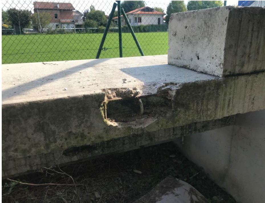
Foto 2: particolare armatura interna alla lastra
