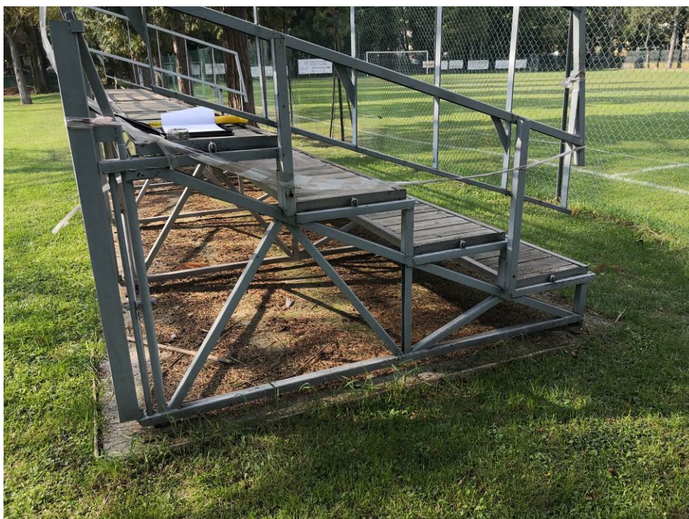
Foto 2: vista del telaio prefabbricato portante
