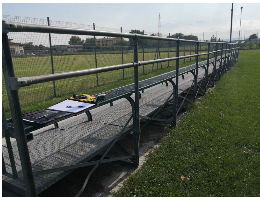
Foto 3: vista posteriore della tribuna con i controventi
