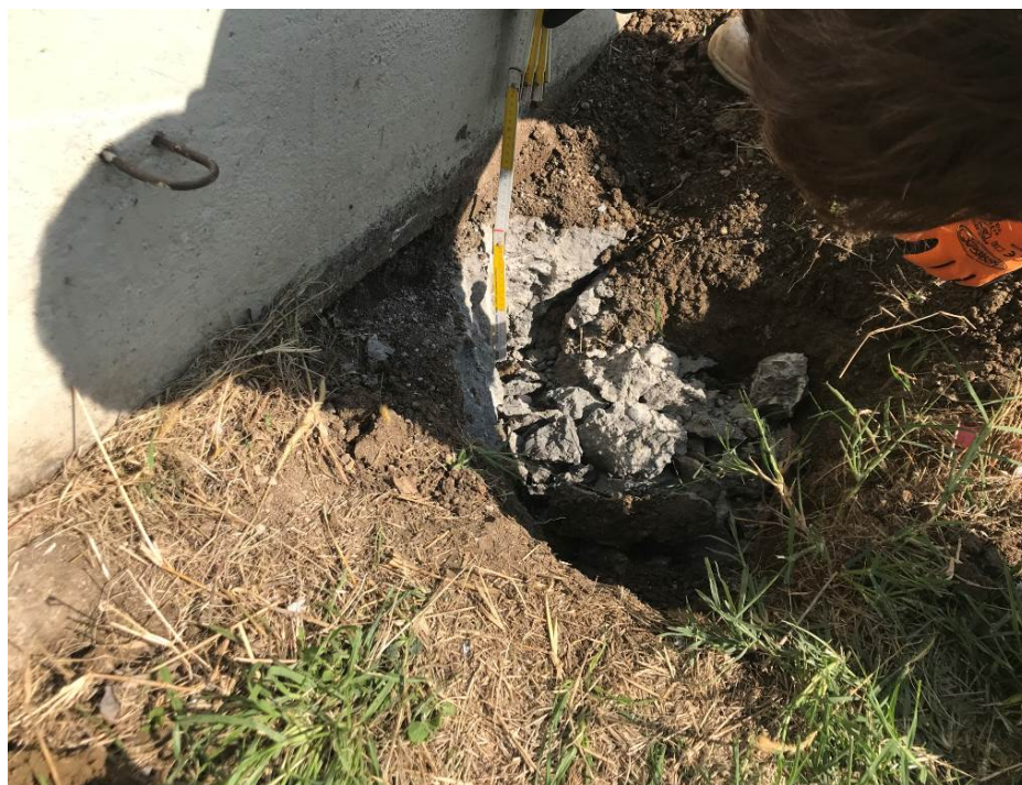
Foto 3: determinazione spessore fondazione
