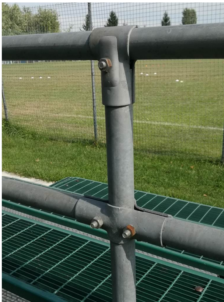
Foto 5: particolare fissaggio parapetto posteriore
