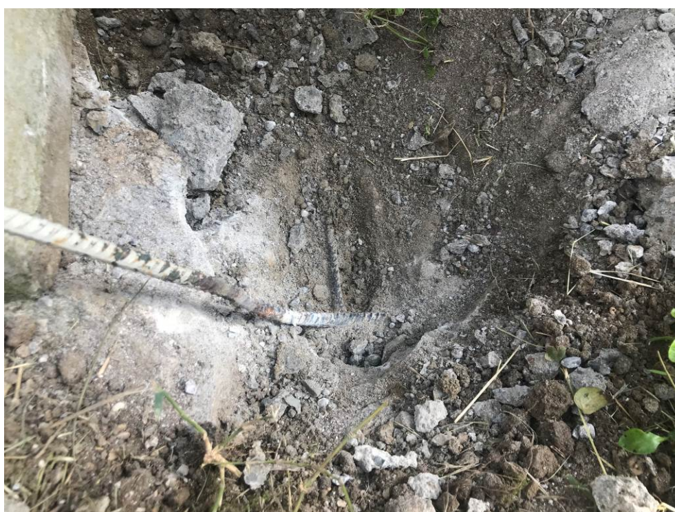
Foto 4: armatura interna alla fondazione
