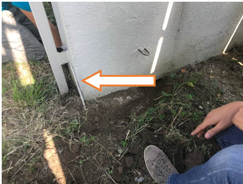
Foto 5: barra di acciaio avente funzione di ancoraggio/controvento
