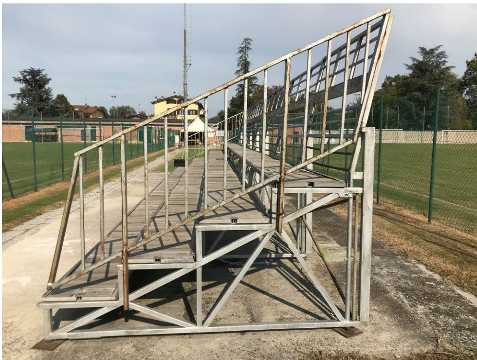
Foto 2: vista del telaio prefabbricato portante
