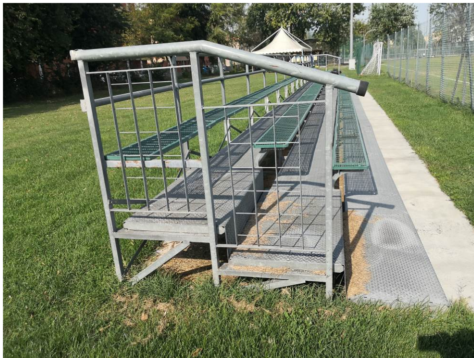
Foto 2: vista del telaio prefabbricato portante, delle sedute e pedate
